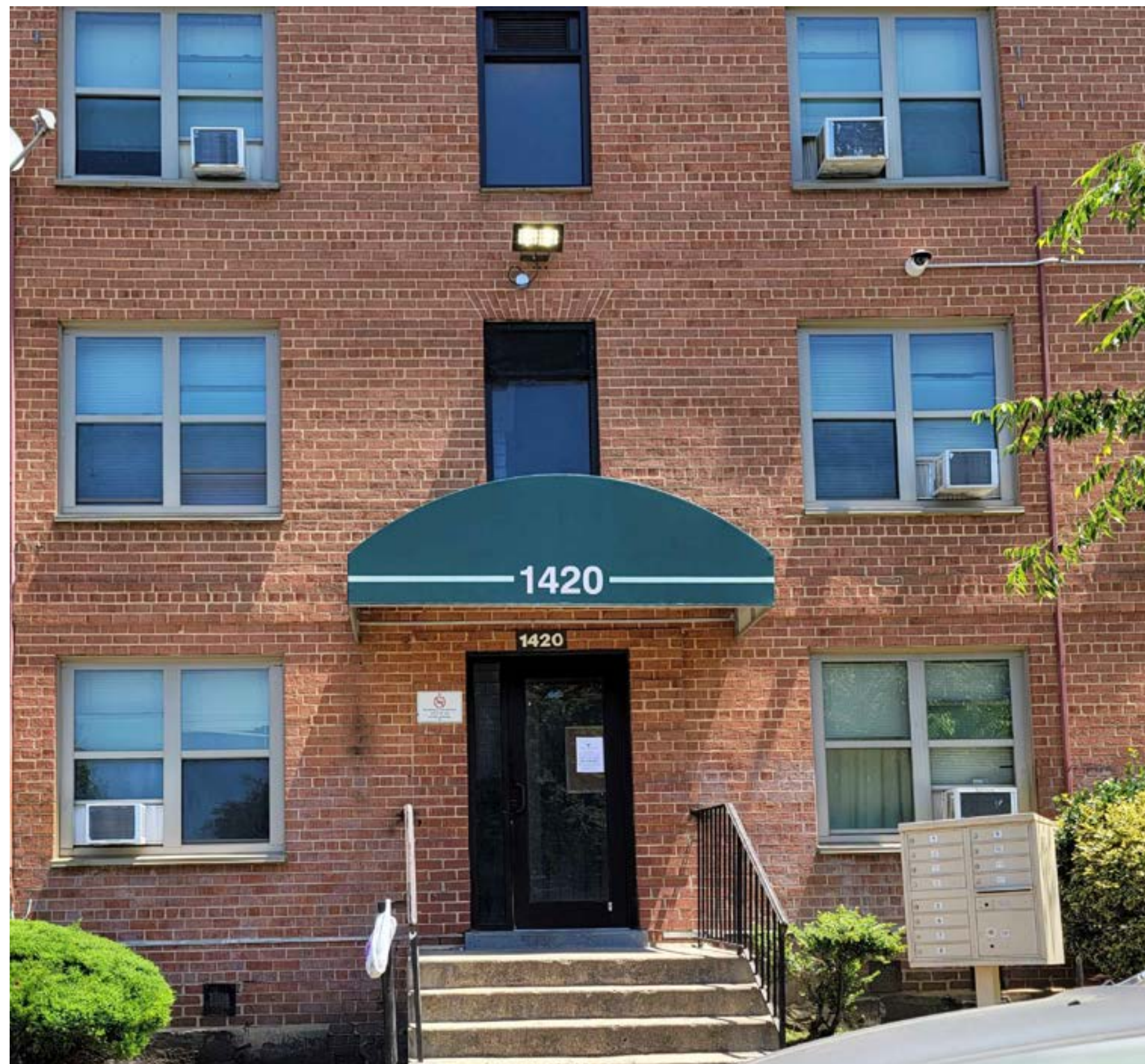
1420 CANAL ST SW
